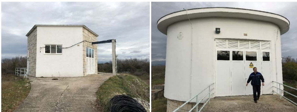
Slika 2.1-5. Zdenca B-4 (lijevo) i B-5 (desno) na vodocrpilištu Bokanjac
