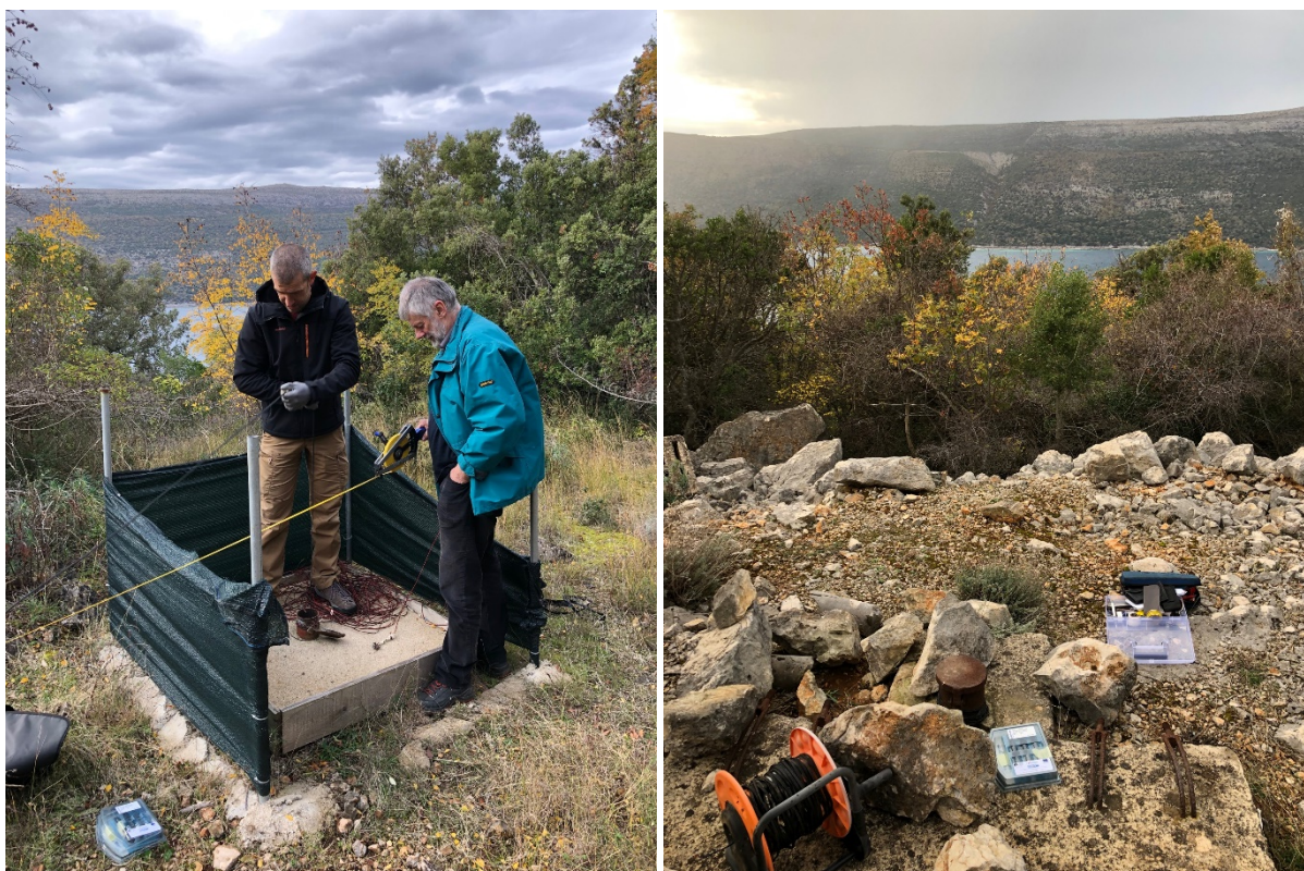
Slika 2.2-9. Postavljanje mjernog uređaja u piezometar PZ-1 (lijevo) i PZ-2 (desno)
