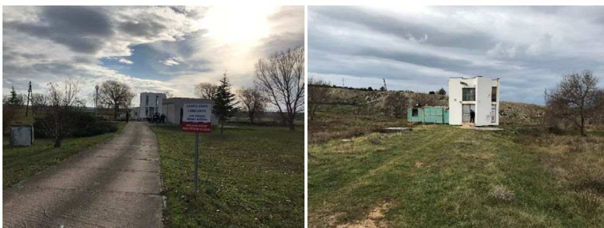
Slika 2.1-6. Vodocrpilište Jezerce (lijevo) i vodocrpilište Boljkovac (desno)
